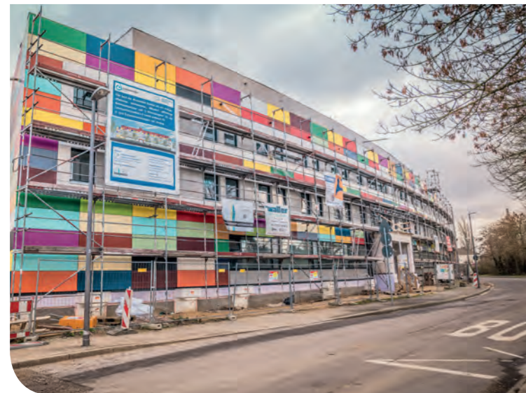
In das Haus mit der kunterbunten Fassade an der Werkstättenstraße werden u. a. Wohngruppen der Lebenshilfe Krefeld einziehen.
