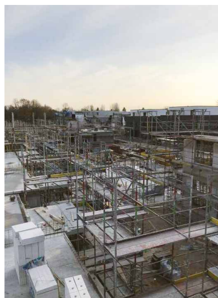
Neubau Herbertzstraße, Stand Januar 2018
