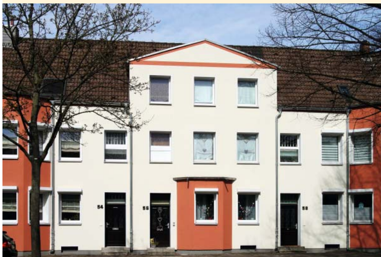
Fassadenanierung Einfamilienhäuser Rathenastraße 36–60
