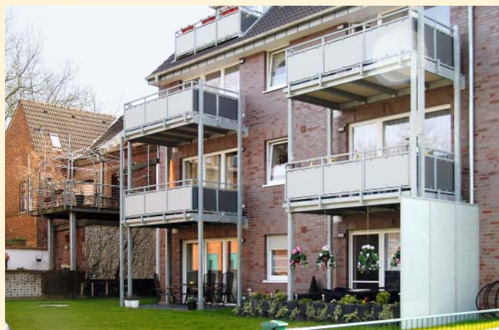
Neubaumaßnahme Mecklenburger Straße 4
