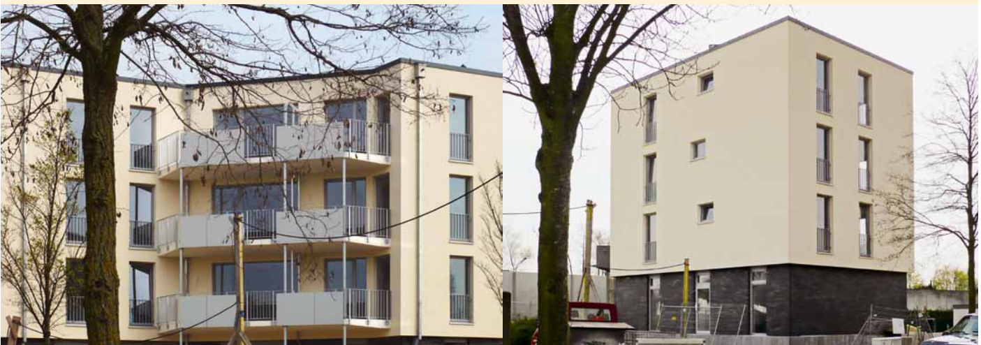
Neubaumaßnahme Auf der Kempener Platte 2/Am Schroershof 26
