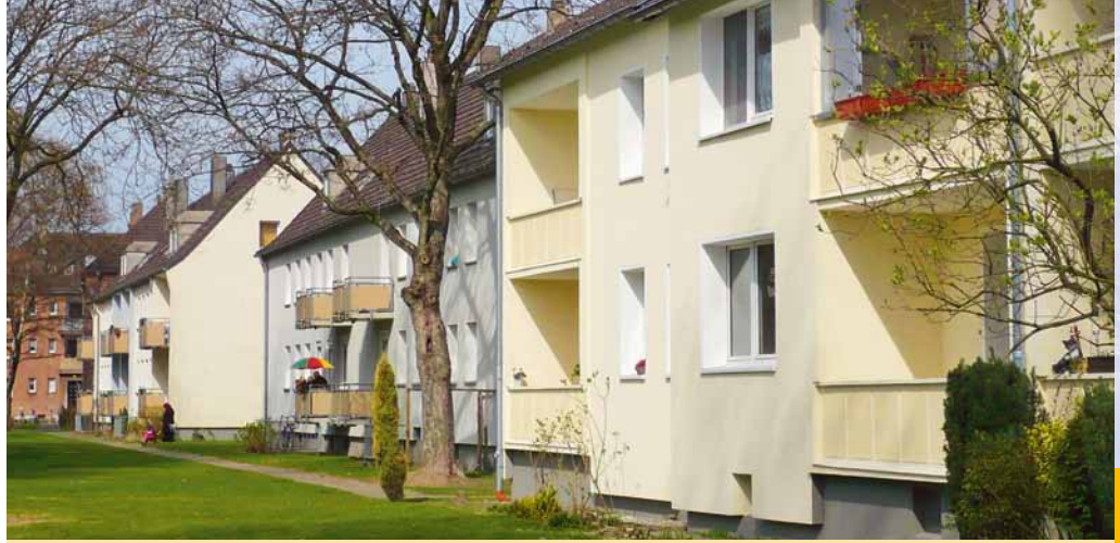
Fassadensanierung Bonifatiusstraße 9 + 11 Rückseite
