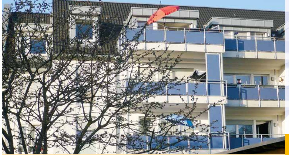
Neubaumaßnahme Traarer Straße 87–89 Rückseite
