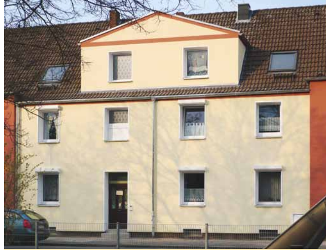
Fassadensanierung Einfamilienhäuser Rathenastraße 36–60
