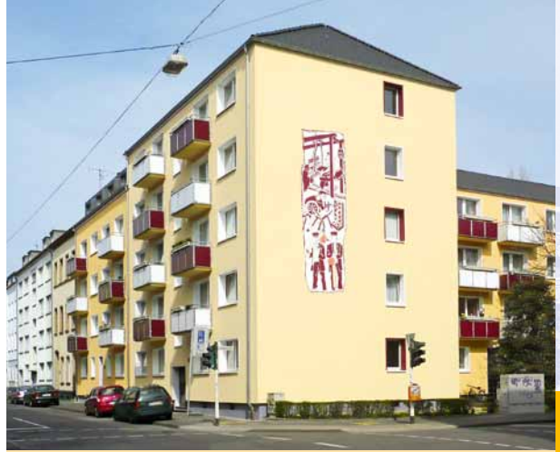
Fassadensanierung Tannenstr. 99, 101/Lewerentzstr. 89, 95
