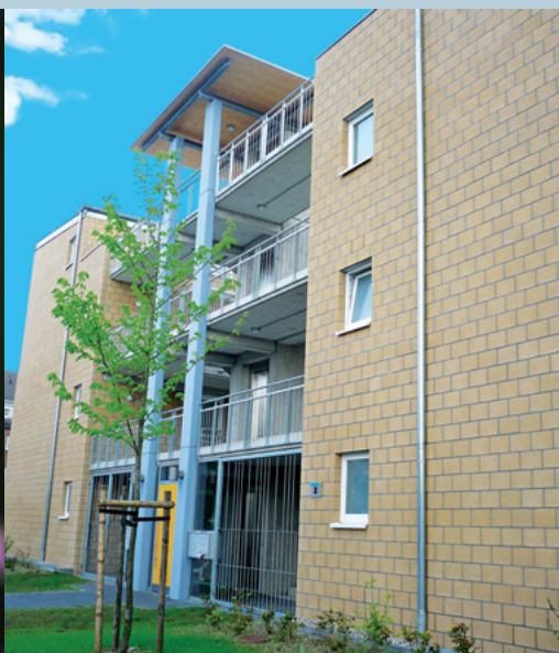
Neubaumaßnahme Kölner Str./Am Dreifaltigkeitskloster
