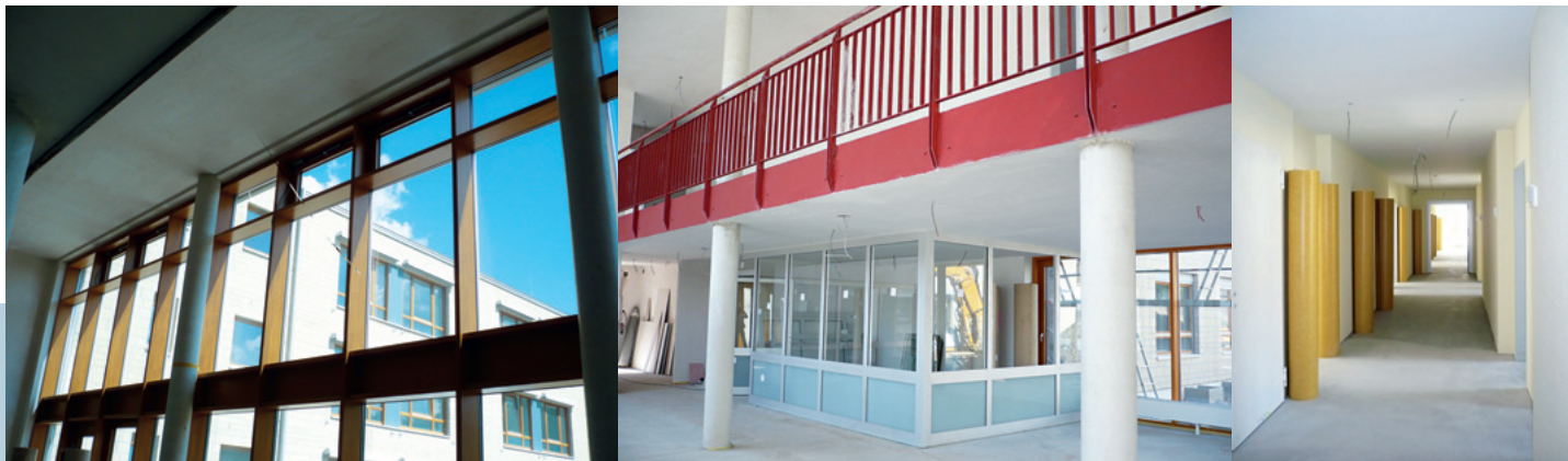
Neubaumaßnahme Seniorenheim Krefeld-Linn
